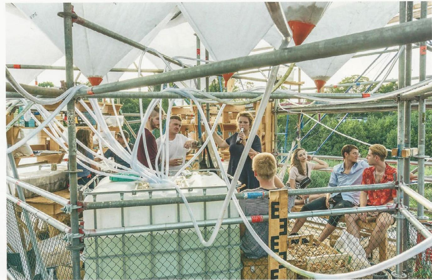
ÜBER DIE DACHKONSTRUKTION DES AUSSICHTSTURMS WIRD REGENWASSER GESAMMELT UND NACH DER FILTRATION IN DAS NUTZWASSERSYSTEM EINGESPEIST.
